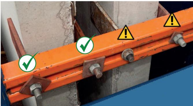
Sichere und unsicher Unterlegplatten an Arretierungselemente
