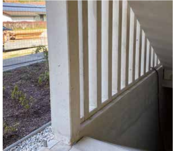
Detail des Treppenhauses mit Verkleidung aus Betonfertigteilen.
