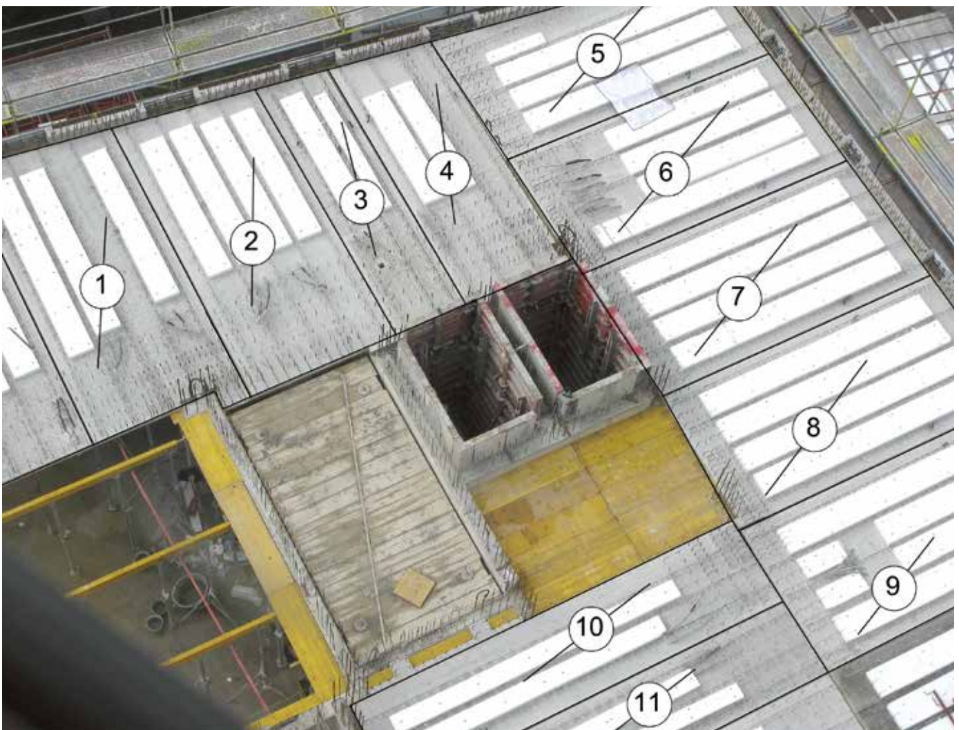
Deckengrundriss mit der Einteilung in vorgefertigte Elemente.
