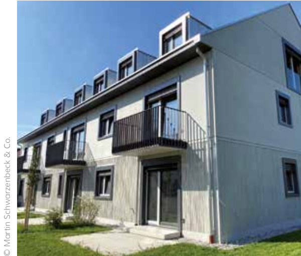
Die Fassade des Mehrfamilienhauses besteht aus Architektur-beton-Fertigteilen.
