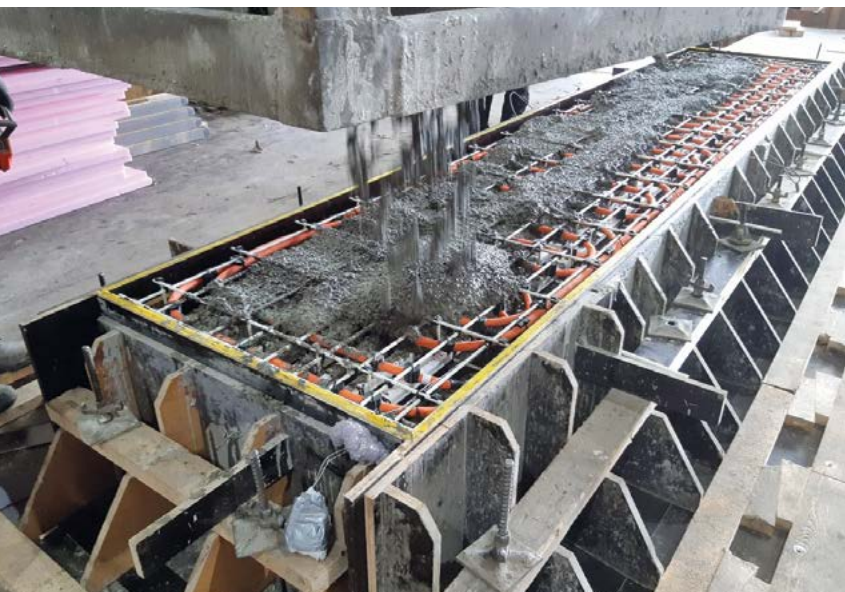
Herstellung eines Fertigteilmoduls mit integrierter Spule.
