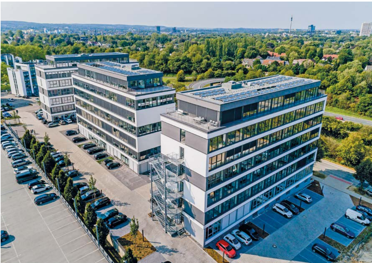
Bürogebäude in Dortmund, Freie-Vogel-Straße: Alle Geschoss- und Dachdecken inkl. der Decke über der Tiefgarage sind mit BRESPA®-Decken hergestellt.
