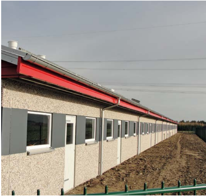
Schweinestall mit wärmegeprägten Wandfertigteilen.
