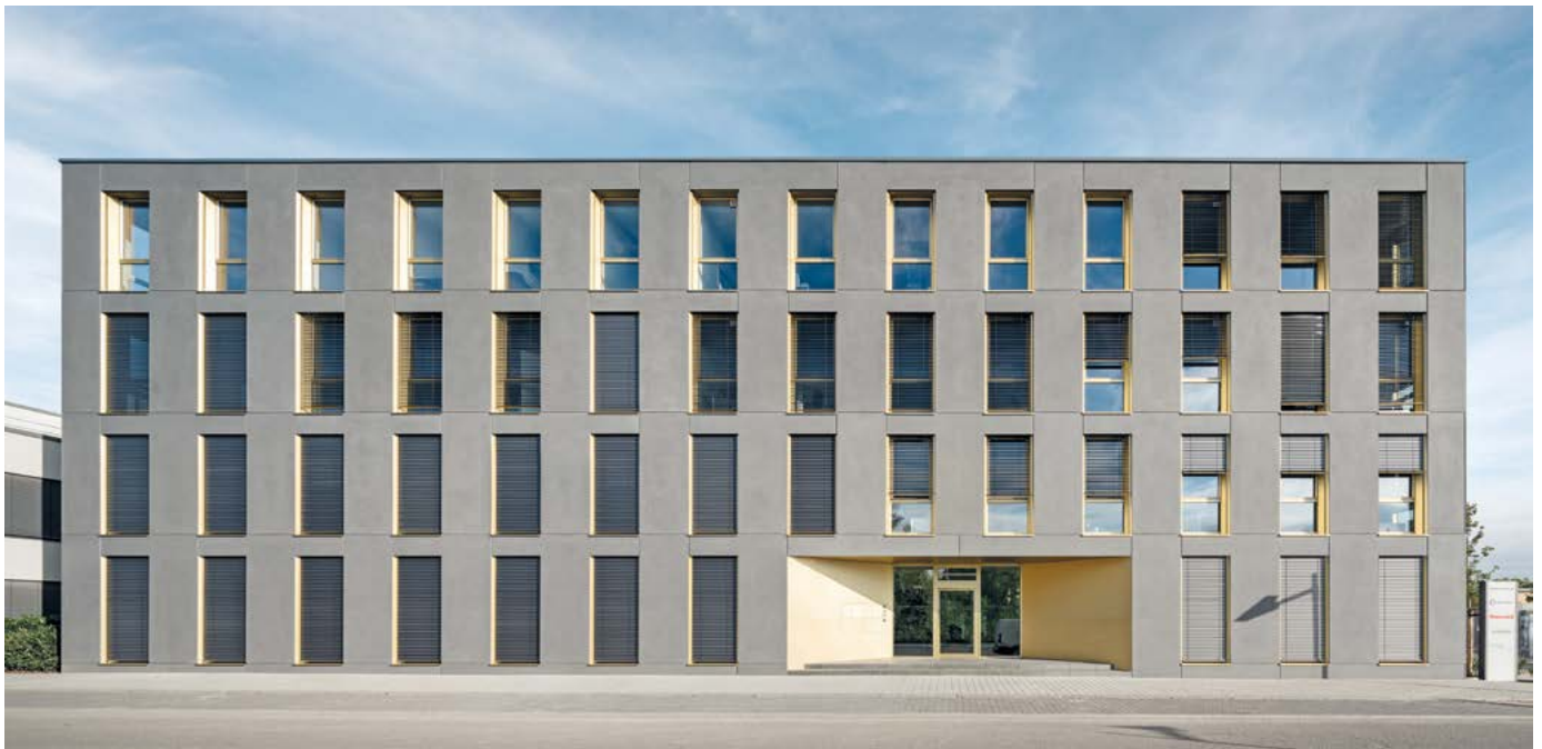
Der Bürobau Eastsite VIII in Mannheim ist das erste Gebäude der Welt, dessen Fassade vollständig als Textilbetonsandwich ausgeführt wurde.
