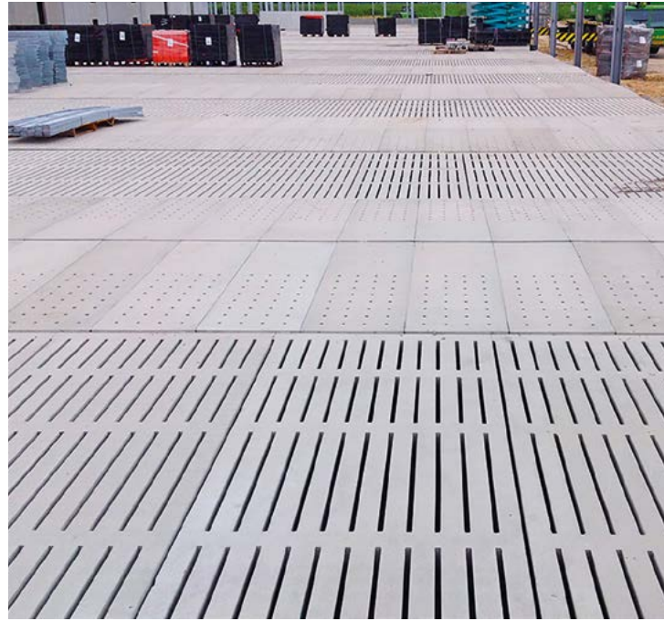
Spaltenböden mit unterschiedlichen Öffnungsanteilen.
