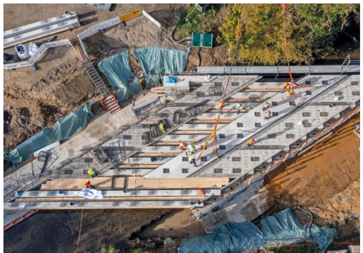
Montage des Überbaus.
