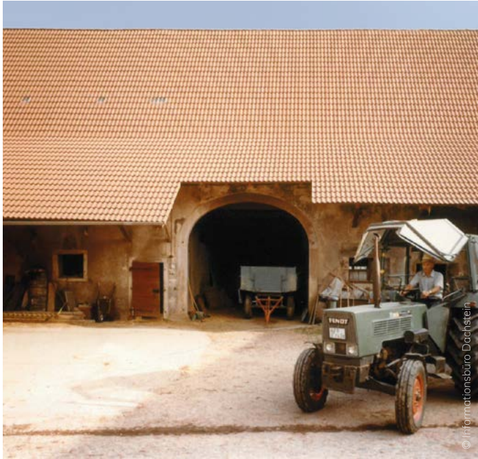
Beton-Dachsteine auf denkmalgeschütztem Bauernhof.
