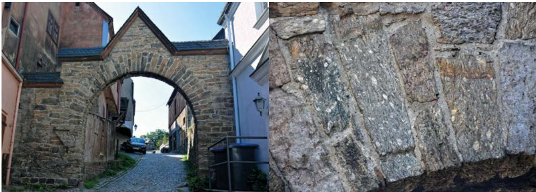
Abbildung 4: Stadttor am Brunnengraben in Schwarzenberg/Erzgebirge. Das bogenförmige Tor mit dreieckigem Abschluss wurde vor allem aus Gneisen errichtet (links). Aufgrund der bau- und ortsgeschichtlichen sowie straßenbildprägenden Bedeutung ist das Tor in die Liste der Kulturdenkmäler der Stadt aufgenommen worden. Sehr gut sind im oberen Bogenbereich die verwendeten Augengneise (rechts) zu erkennen (Foto: UVMB).
