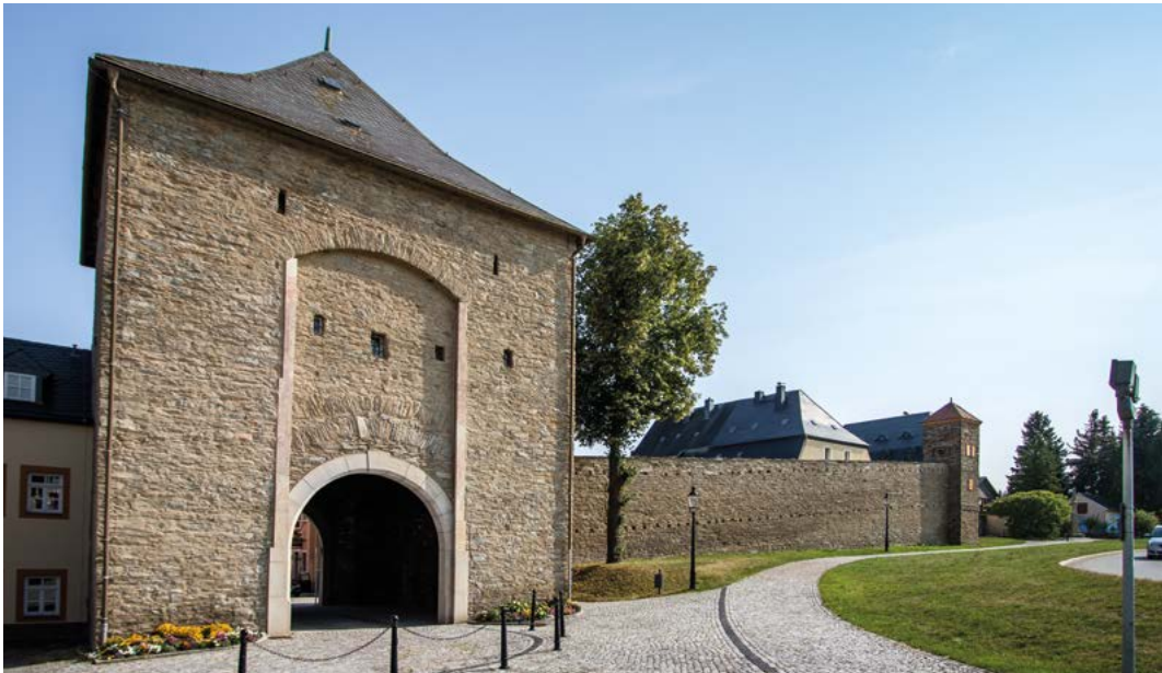
Abbildung 2: Zschopauer Tor in Marienberg. Das Zschopauer Tor ist das einzige noch erhaltene Tor von ehemals fünf Stadttoren in Marienberg. Rechts und links stehen auch noch Reste der ehemaligen Stadtmauer, welche von 1541 bis 1566 erbaut wurde (Foto: UVMB).
