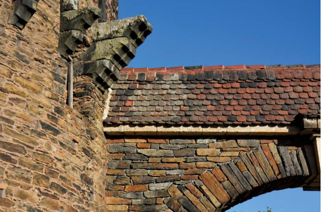
Abbildung 3: Donatsturm – einziger runder Turm der mittelalterlichen Stadtbefestigung von Freiberg aus dem 15. Jahrhundert. Der Turm wurde überwiegend unter Verwendung des Freiburger Graugneises, einem Biotitparagneis, errichtet (Foto: UVMB).
