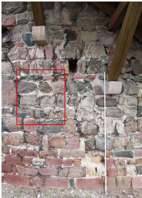
Abbildung 4: Südöstlicher Teil des Bergfrieds der Rothenburg unterhalb der Außentreppe. Das Bruchsteinmauerwerk besteht aus dunklen Gneisen, hellen Metagraniten, Gangquarzen und Kalksilikatfelsstücken sowie rötlichen Kyffhäuser-Sandsteinstücken (Foto: M. P. Hofsaess und L. Romstedt, Thermik Gerätebau GmbH, 2019).
