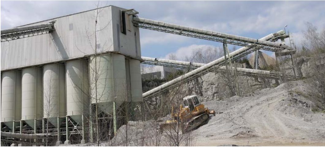
Abbildung 3: Die Aufbereitung des Gneis erfolgt in hochwertige Schotter- und Splittprodukte, die vor allem im Straßen- und Verkehrswegebau und zur Herstellung von Beton- und Asphaltmischgut zum Einsatz kommen.
