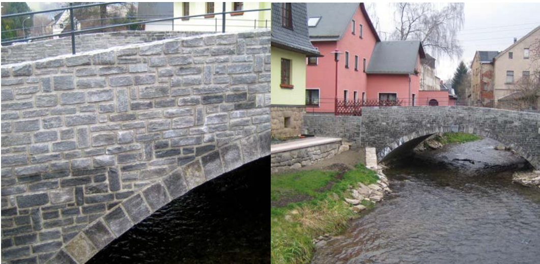
Abbildung 2: Sanierung einer Brücke in Raschau/Erzgebirge mit Dörfler Gneis im Jahr 2009.
