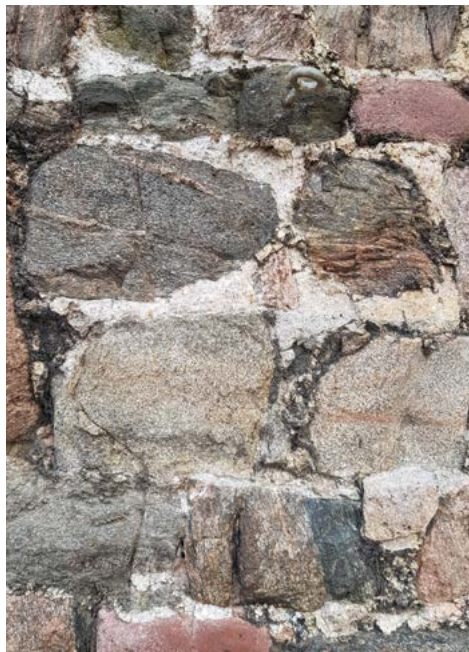
Abbildung 5: Detail der Außenschale des Bergfrieds. Dunkle Gneise mit Paralleltextur und Quarzadern im oberen Drittel des Bildes. Darunter liegen helle Metagranite und wiederum Gneise. Optisch besonders auffällig die roten Kyffhäuser-Sandsteine oben und unten (Foto: M. P. Hofsaess und L. Romstedt, Thermik Gerätebau GmbH, 2019).
