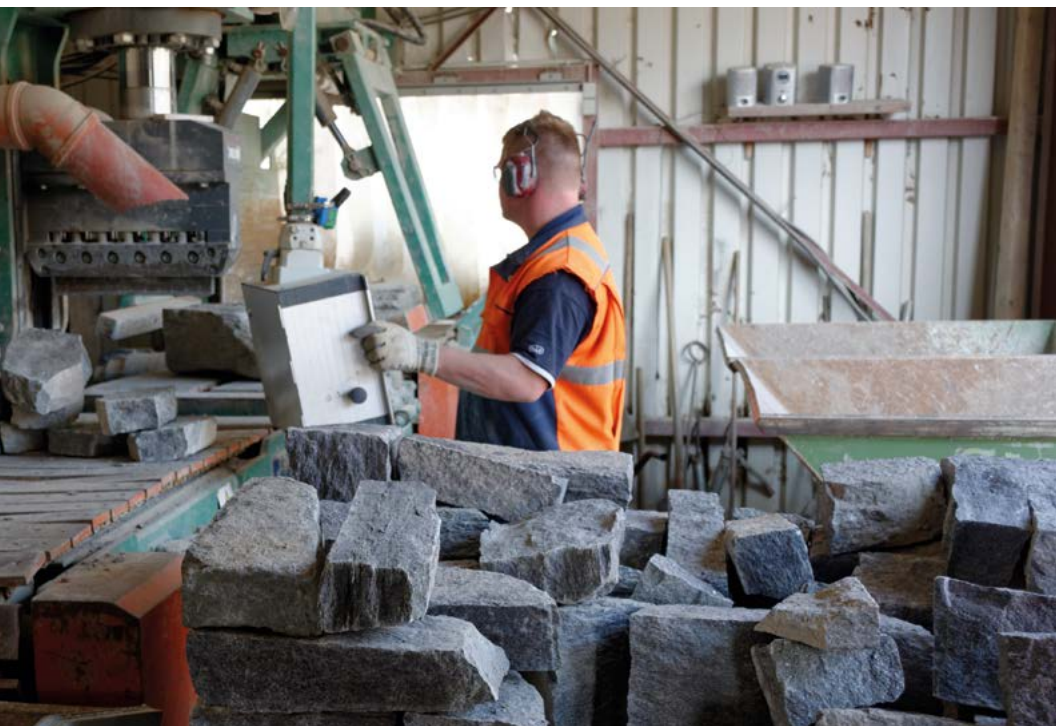
Abbildung 4: Mithilfe einer Spaltmaschine werden aus dem Dörfler Gneis verschiedene Sortimente von Naturwerkstein, die sich in Form und Größe unterscheiden, hergestellt.
