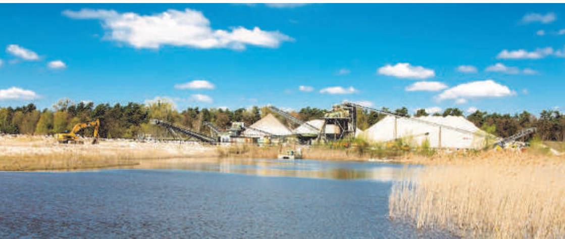
Abbildung 5: Kieswerk Hartmannsdorf mit Aufbereitungsanlage.
