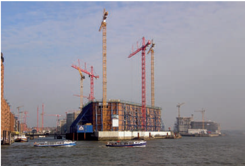
Abbildung 1: Die Baustelle der Elbphilharmonie in Hamburg im Oktober 2008. Allein für die Herstellung des verbauten 63.000 Kubikmeter Transportbetons (s. Text) wurden rund 41.000 Tonnen Bausand hoher Qualität benötigt (Foto: Emma7stern/Wikipedia).
