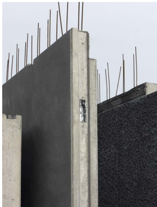
Abb. 4.1: Massive Wandelemente mit Anschlussbewehrung
