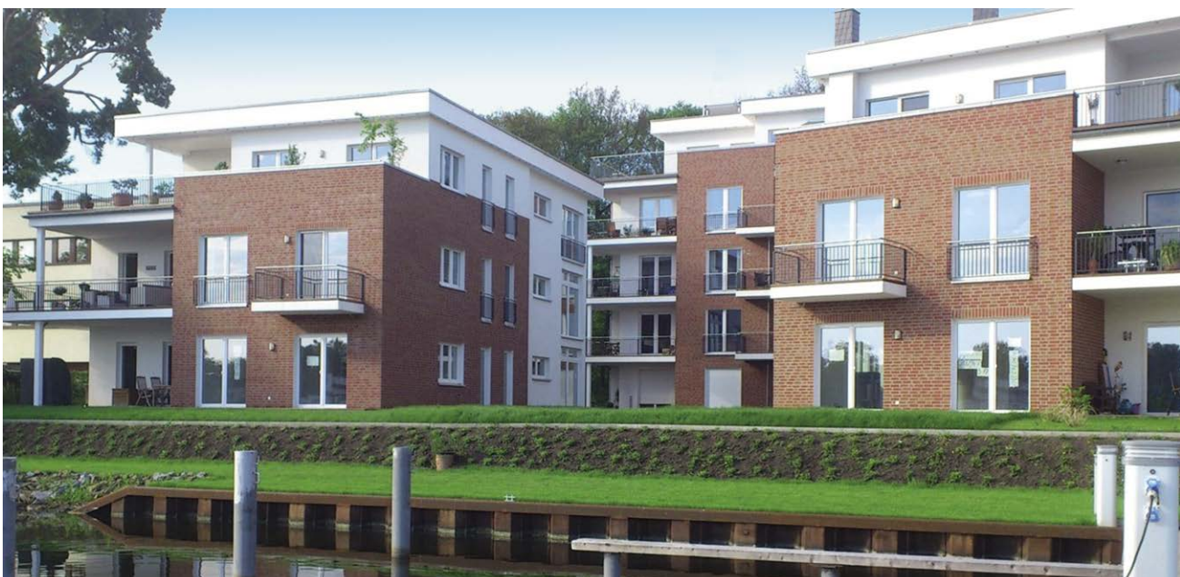
Abb. 4.4: Mehrfamilienhaus aus Leichtbeton mit verkleinerter Fassade
