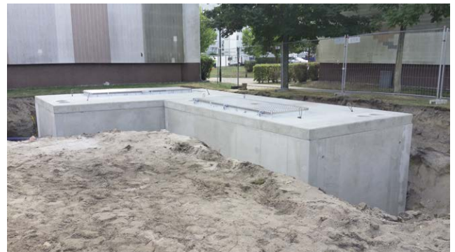
Abb. 13.4: Je nach System wird die im Betonfertigteilwerk hergestellte Raumzelle für die Technische Gebäudeausrüstung (TGA) in eine Baugrube gesetzt.
