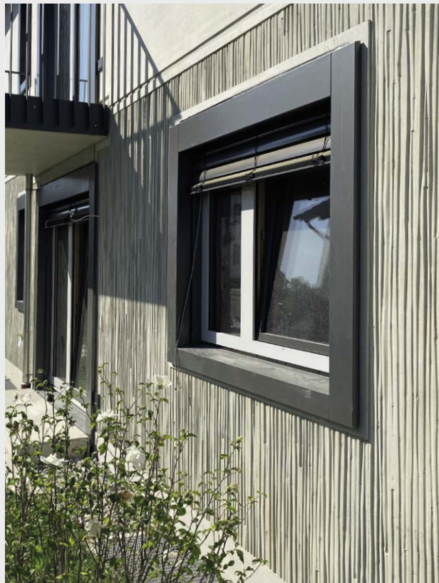
Abb. 16.2: Detailansicht der Fassade mit Rillenstruktur
