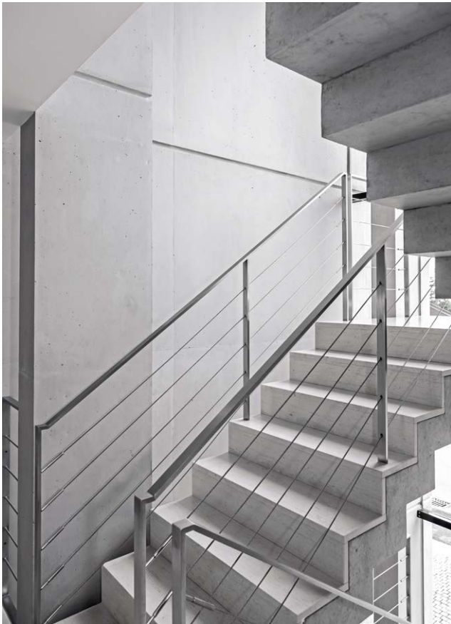
Abb. 7.3: Betonfertigteiltreppe mit Belag aus Betonwerkstein
