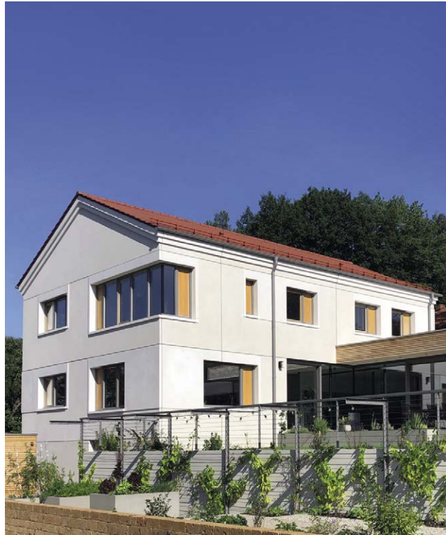
Abb. 5.3: Wohnhaus mit Fassade aus Sandwichelementen
