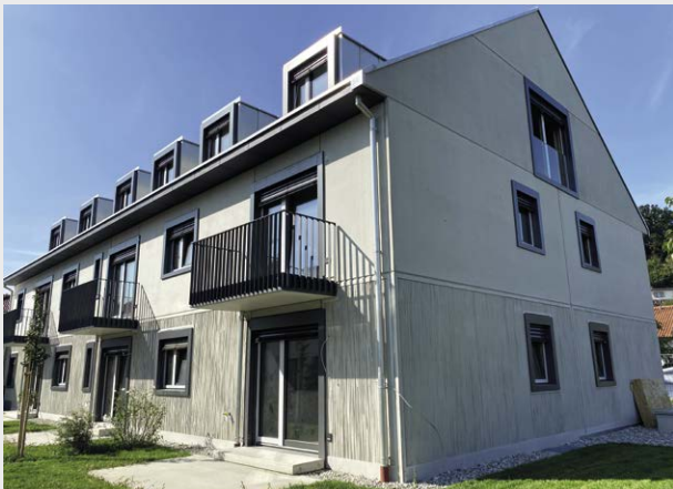
Abb. 16.1: Mehrfamilienhaus mit einer Architektur-Fertigteilfassade aus Beton
