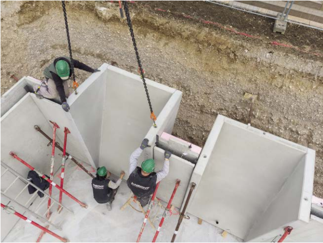
Abb. 9.3: Montage von Lichtflutern auf der Baustelle
