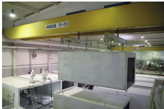
Abb. 6.2: Vorfertigung der Raummodule im Werk
