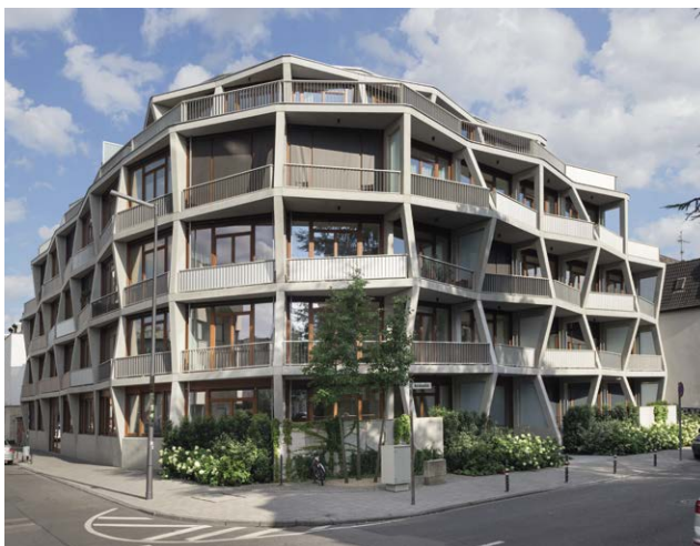
Abb. 1.1: Aufgelöste Fassade mit Architekturbetonfertigteilen
