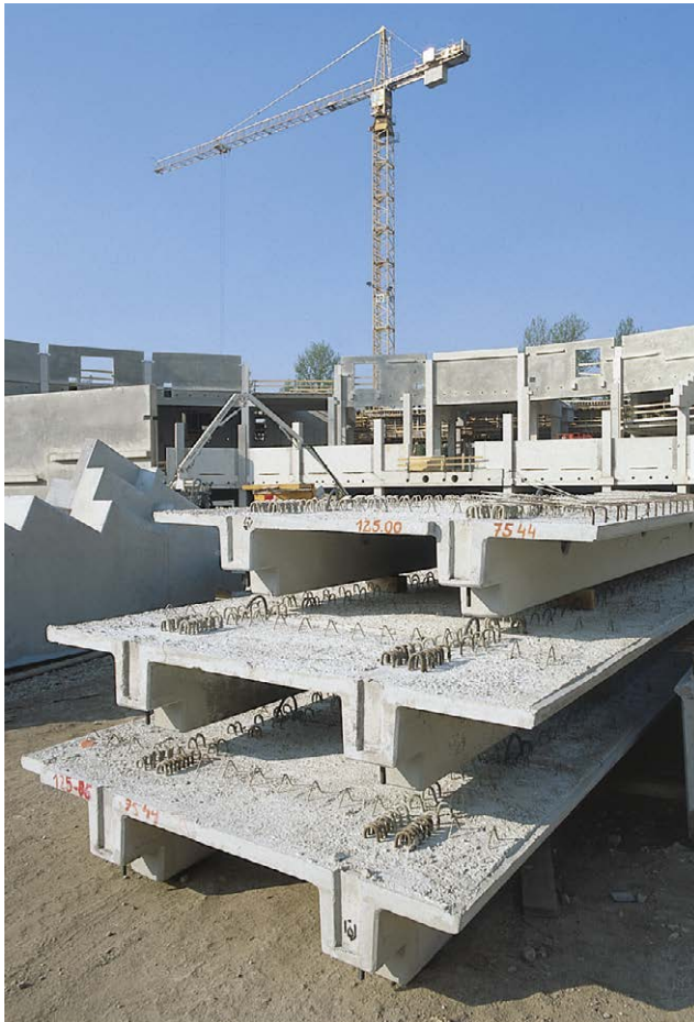
Abb. 3.4: TT-Platten vor dem Einbau
