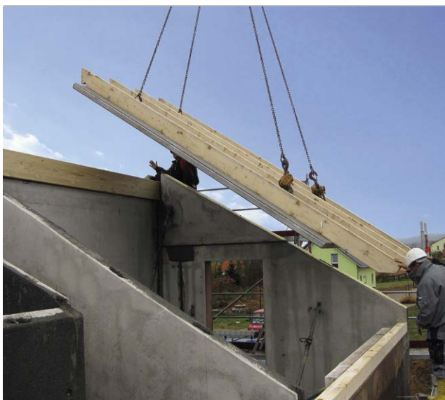
Abb. 10.1: Einbau eines Massivdaches
