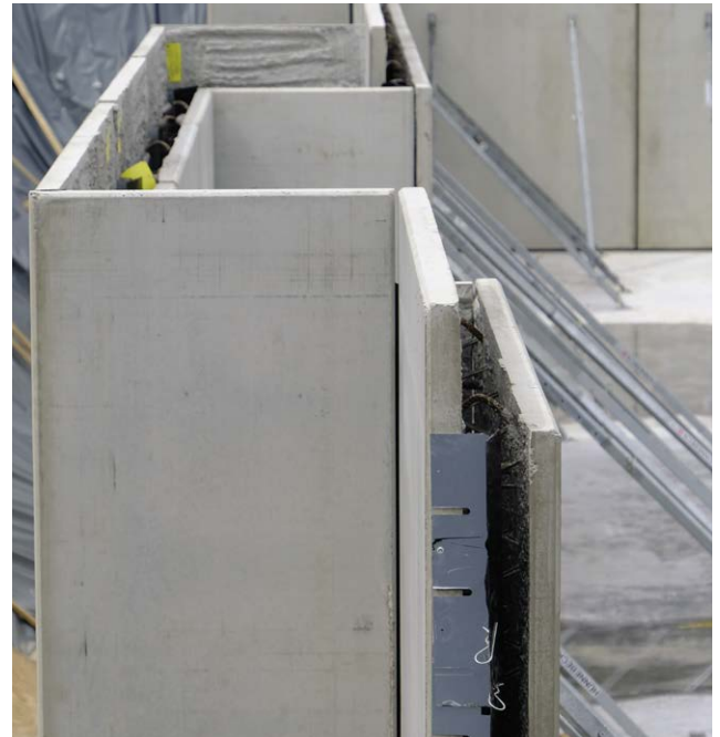
Abb. 4.3: Erstellung einer Kelleraußenwand mit Elementwänden
