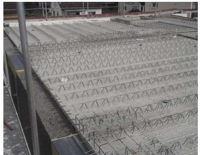
Abb. 3.2: Elementdecke fertig verlegt
