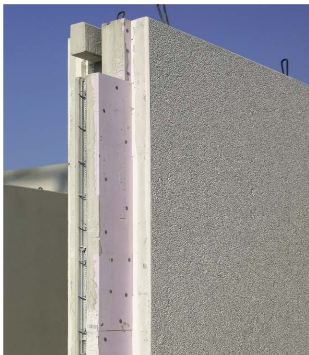
Abb. 5.4: Detailansicht einer Sandwichwand
