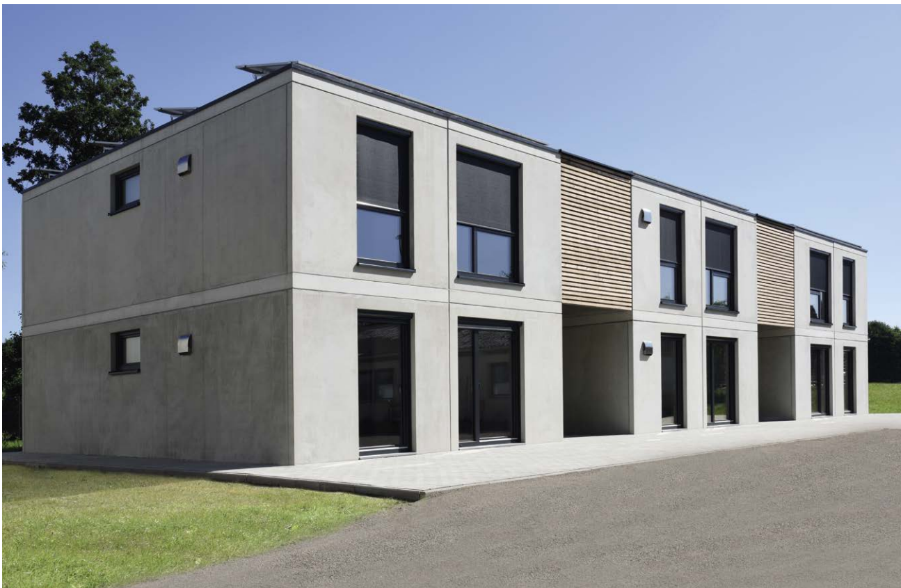
Abb. 6.1: Mehrfamilienhaus aus Raummodulen
