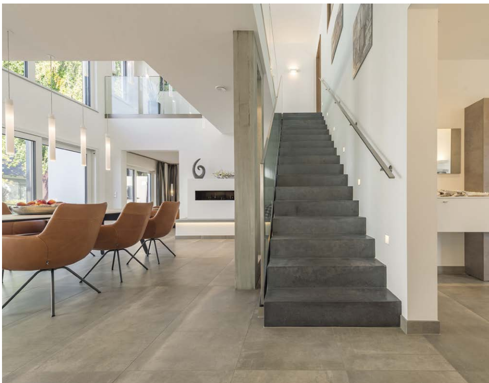
Abb. 7.1: Betonfertigteil-treppe in Sichtbetonqualität als Gestaltungselement
