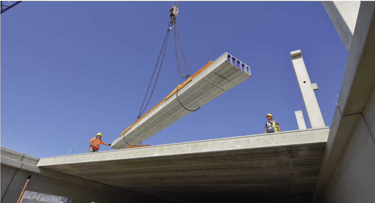
Abb. 3.3: Verlegung von Spannbeton-Fertigdecken
