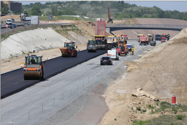
Abb. 3: Baustelle Straßenbau: Rohstoffbedarf Gesteinsrohstoffe 87.000 t/km Bundesstraße
