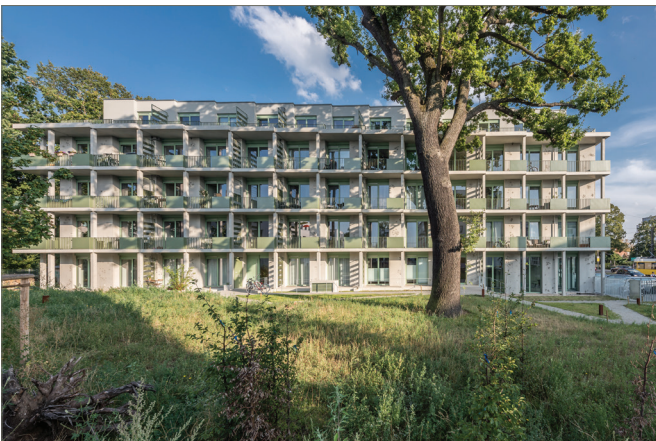
Abb. 3: Wohnhaus mit selbsttragender Fassade aus Sichtbetonfertigteilen und Balkonwänden in Berlin, Lindenstraße 2-4
