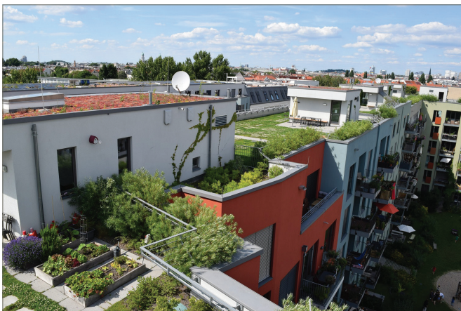
Abb. 4: Dachbegrünung im urbanen Raum Berlins
