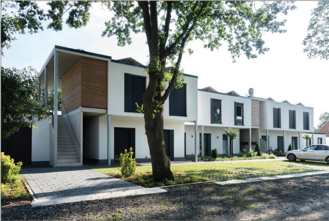
Abb. 2: Modulares Mehrfamilienhaus als passgenaue Lösung für innerstädtische Nachverdichtung und Bauen im Bestand
